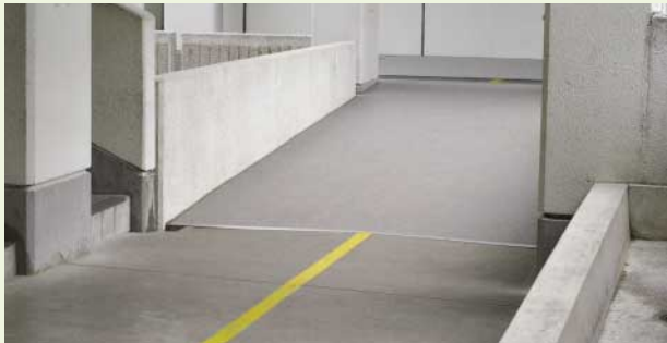
バリアフリー化された川南小学校
