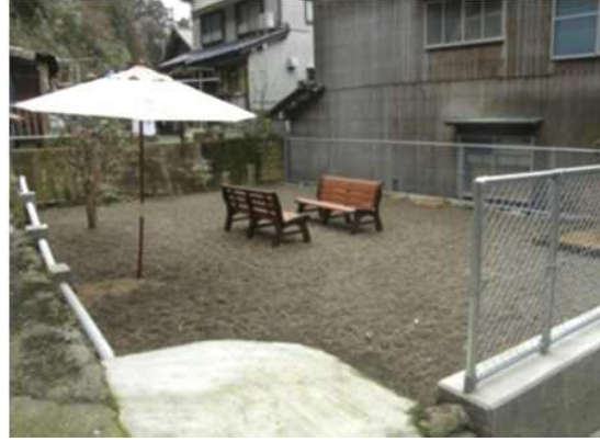
危険空家【解体後】
