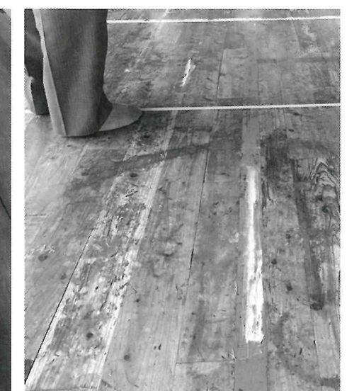
多賀小学校体育館床
