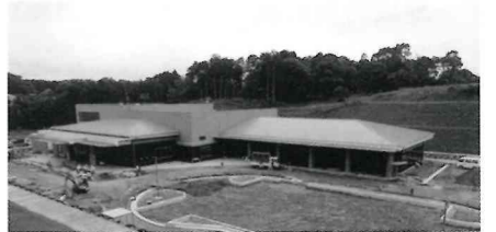
工事中の西都児湯斎場「再生の杜」
