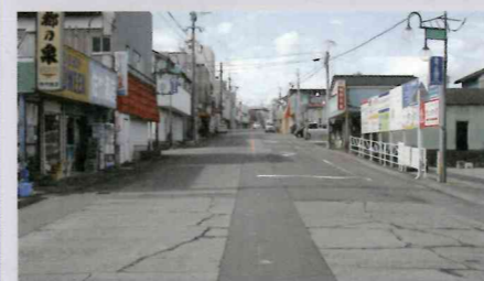
商店街の道路 上は工事後、下は工事前
