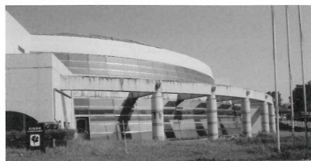
今回修理する図書館外廻り
