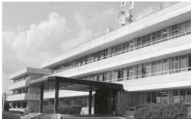
昭和49年に建設された川南町役場庁舎
