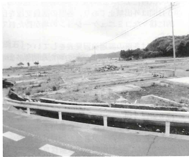
いわき市薄磯海岸付近 建物等建造物は全て流されている。住宅街だった様だが人の姿はない。
