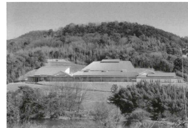
観音寺市斎場「燧望苑」の全景
