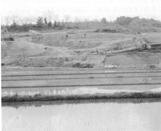
矢吹町西方の白河市境付近 高台が崩落し複数の重機で突貫の復旧工事をしていました。
