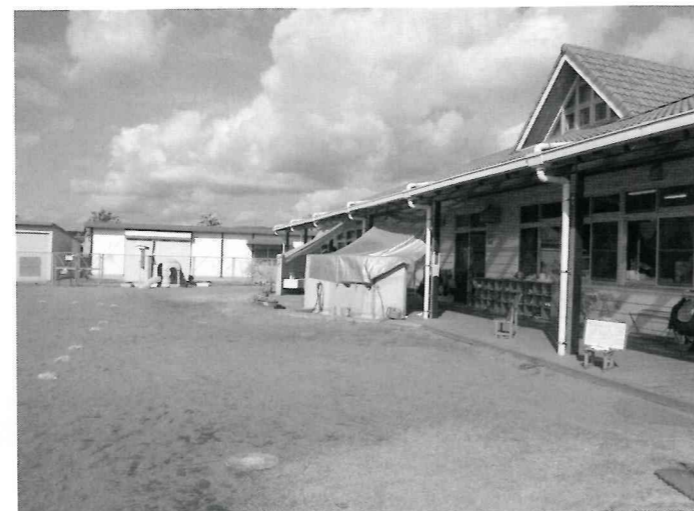
中央保育所デッキ工事
