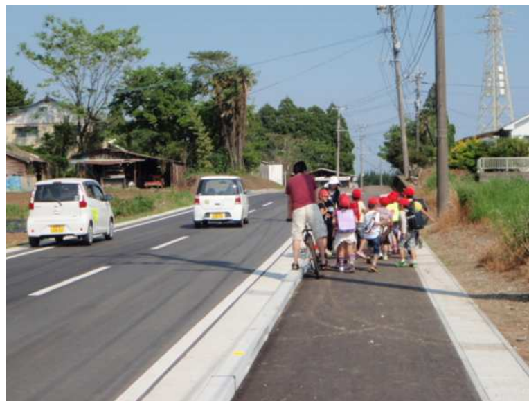
整備済み状況
