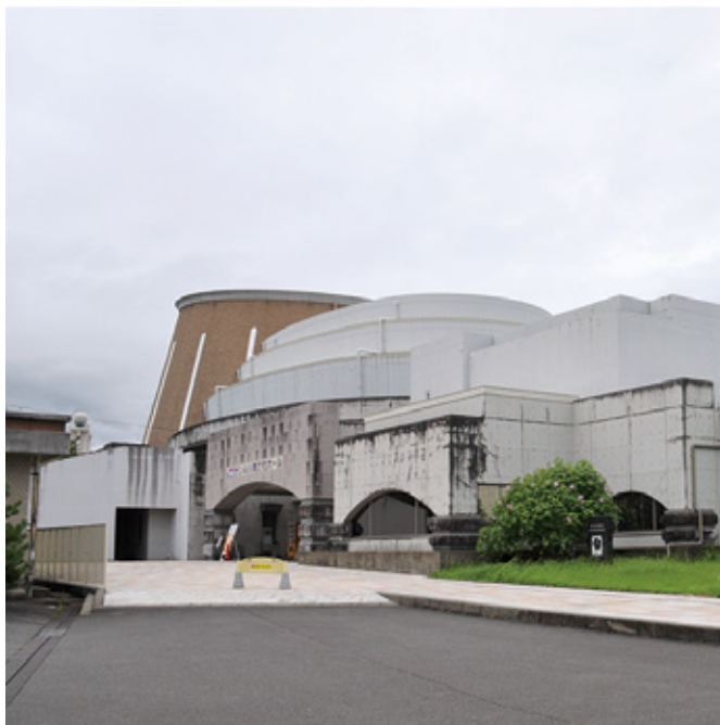
サンA川南文化ホール正面付近
