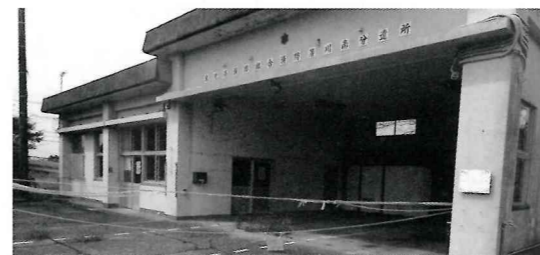
改修される分遣署跡
