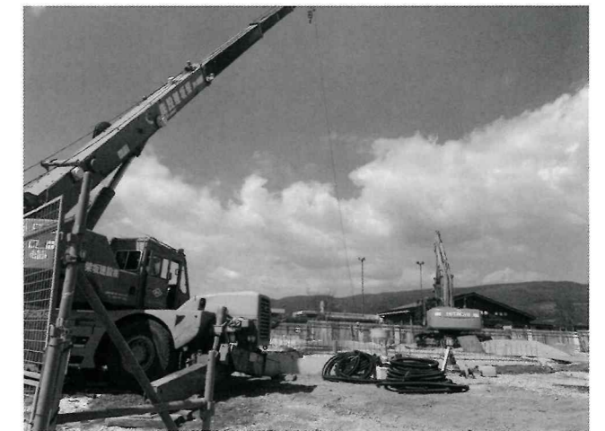
来年4月オープンに向け、工事が進むPA物産館
