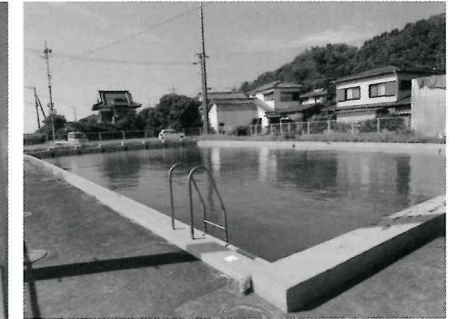
プールについても解体となる
