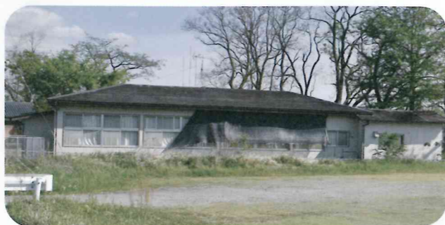
建設予定地は現川南別館の西側空地
