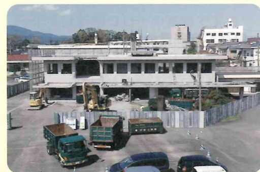
解体中の川南町公民館
