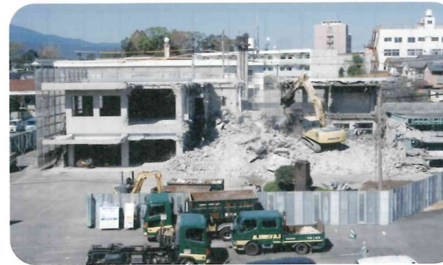
解体工事中の町公民館
