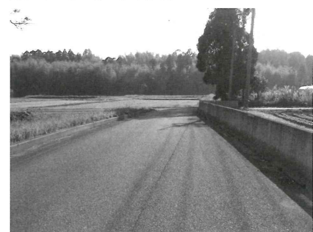
川北南橋の取付道路
