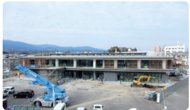
着々と工事が進む福祉センター 1月17日現在
