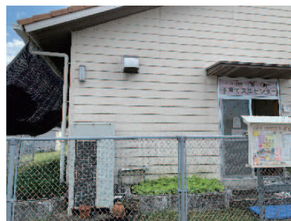
この部分を改修
