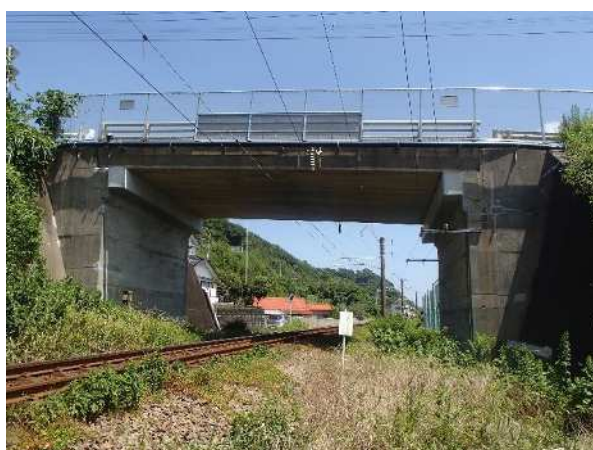
図 9 鉄道を跨ぐ橋梁の例（川南町管理 えびす橋）
