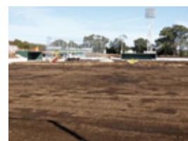
野球場の改修工事
