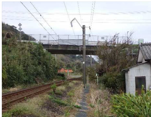
図 10 鉄道を跨ぐ橋梁の例（川南町管理 えびす橋）
