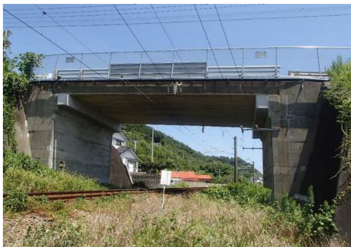
図 10 鉄道を跨ぐ橋梁の例（川南町管理 えびす橋）
