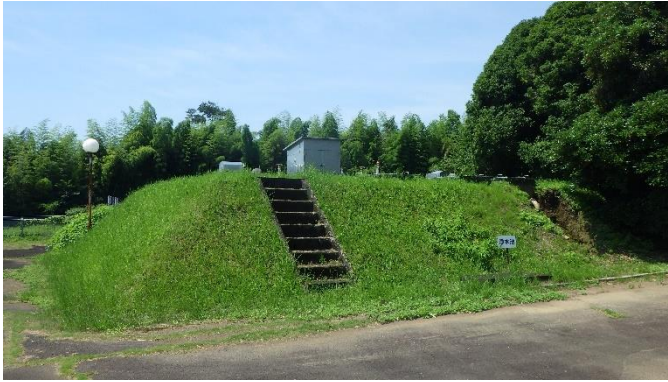
浄水池 昭和54年度建設 RC造 193 m 3
