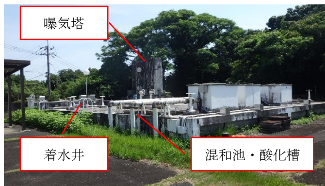
遊離炭酸除去設備等 昭和54年度建設
