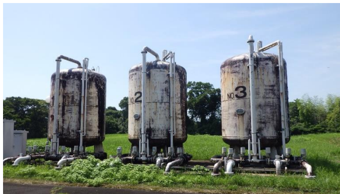
除鉄・除マンガン設備 昭和54年度建設
