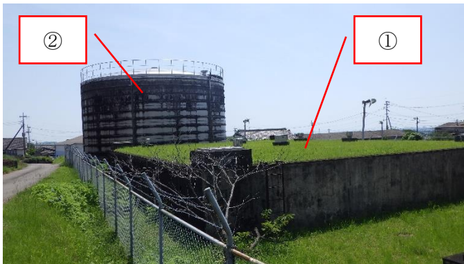
① RC造 593 m 3 昭和51年度建設 ② SUS製 800 m 3 平成7年度建設
