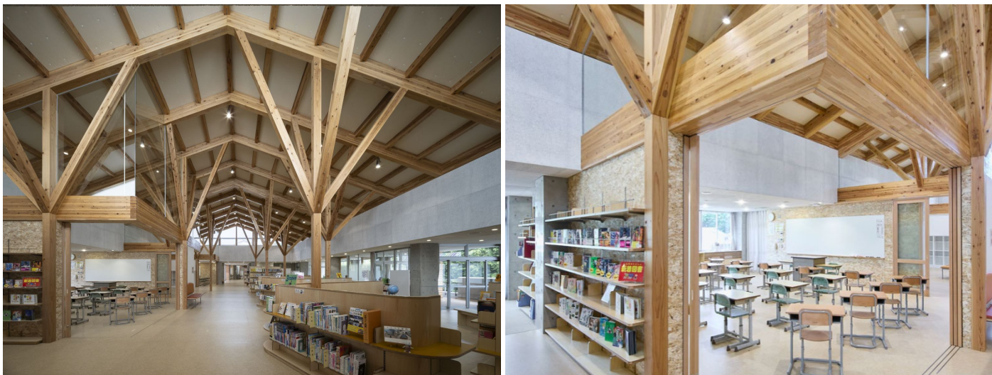
▲教科教室型の教科Lab.(オープンスペース)の事例 [ 邑南町立石見中学校 ]
