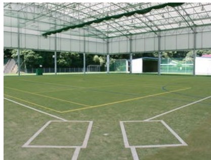
▲屋根付多目的運動場
