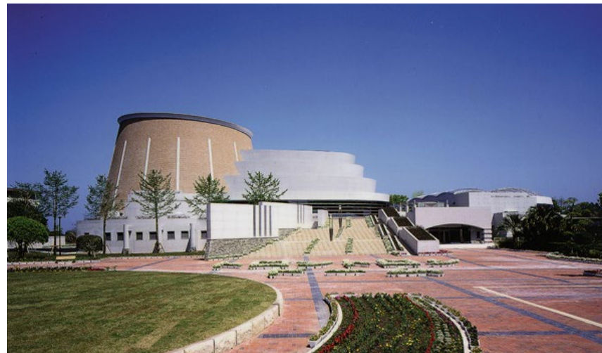
▲サンA川南町文化ホール・図書館（トロントロンドーム）
